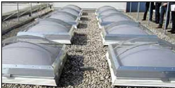
**Abb. 23:** Hagelschutzgitter für Lichtkuppeln (Quelle: VGH)
